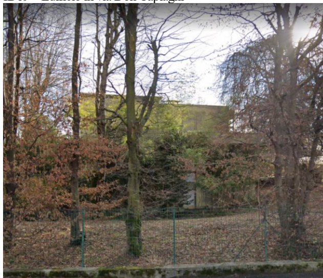
ID09 – Edificio in via Don Capiaghi
