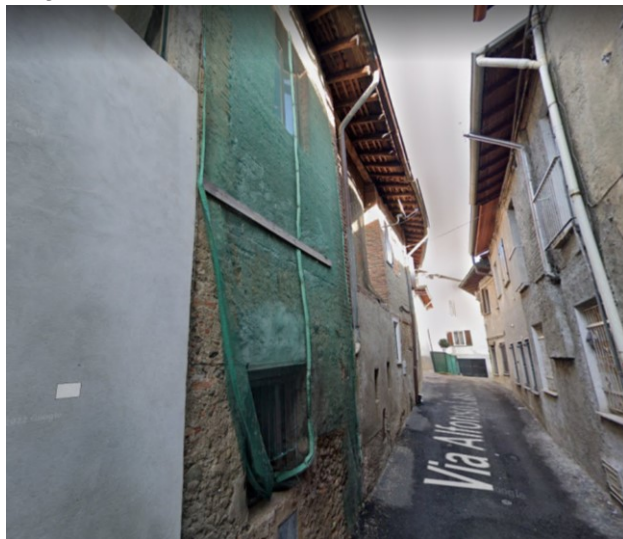
ID13 – Edificio in via Lamarmora
