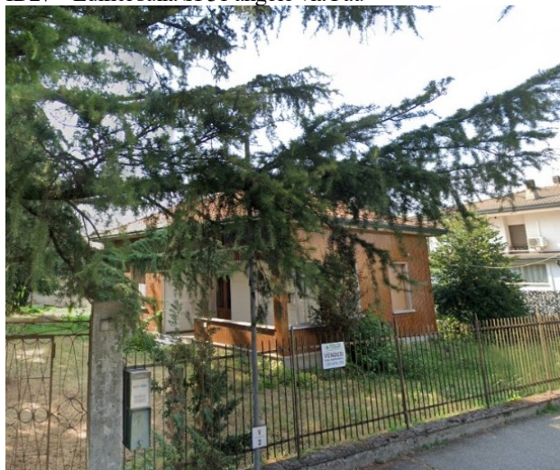
ID27 – Edifici sulla SP31 angolo via Paù
