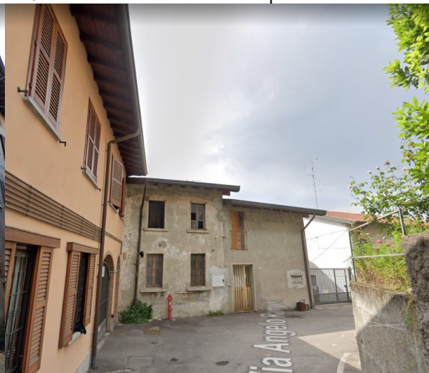
ID19 – Porzione di edificio in via Rampoldi
