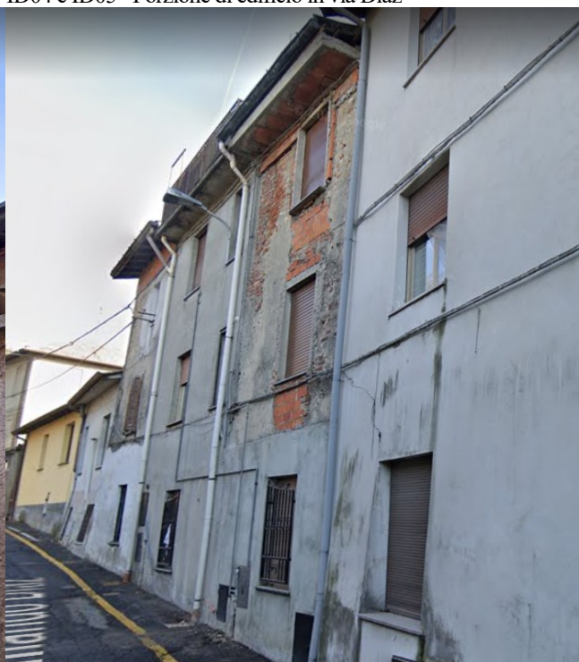
ID04 e ID05 – Porzione di edificio in via Diaz
