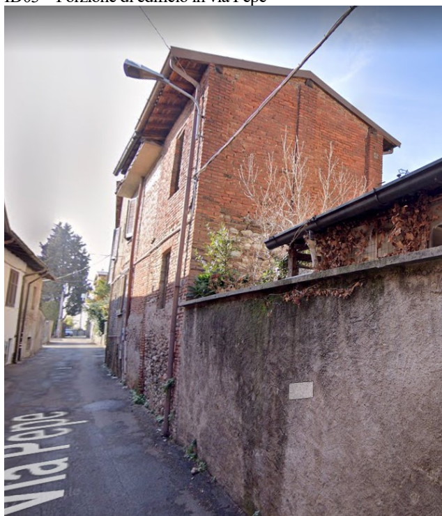
ID03 – Porzione di edificio in via Pepe
