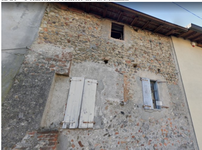
ID20 – Porzione di edificio in via Mazzini
