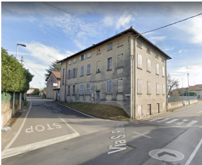
ID12 – Edificio in via San Rocco
