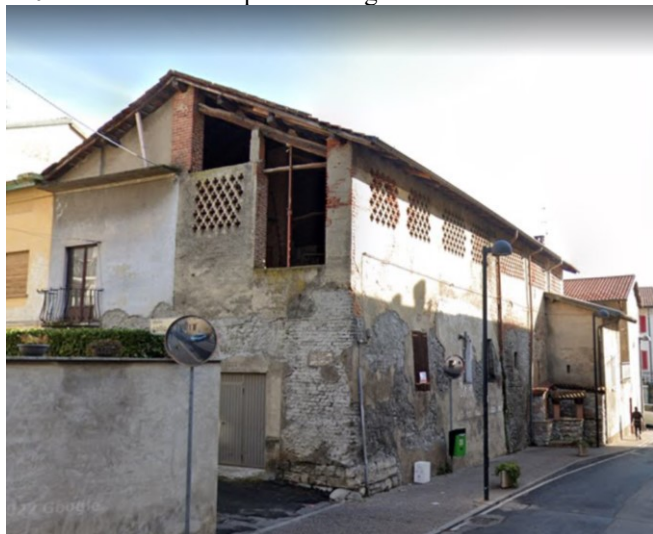
ID01-Edificio in via indipendenza angolo vicolo Gallo
