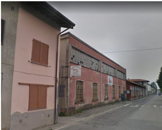
ID10 – Edificio in via Garibaldi
