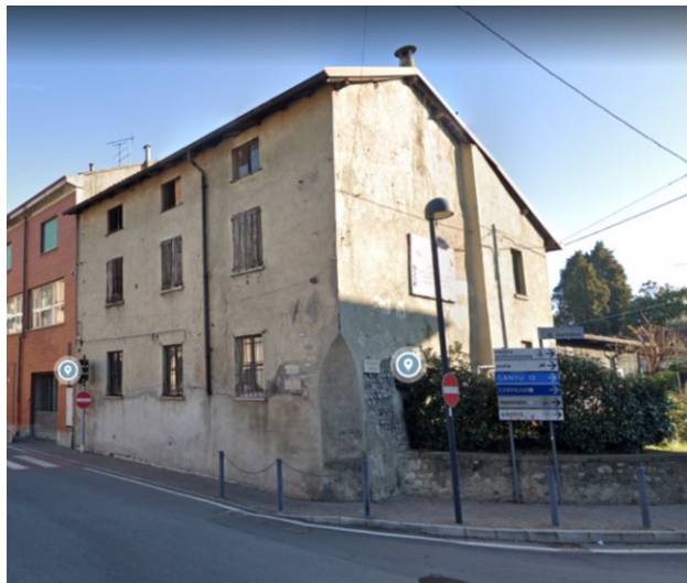
ID11 – Edificio in via Garibaldi
