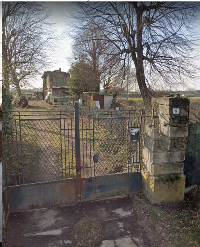
ID07 – Edificio in via Kennedy
