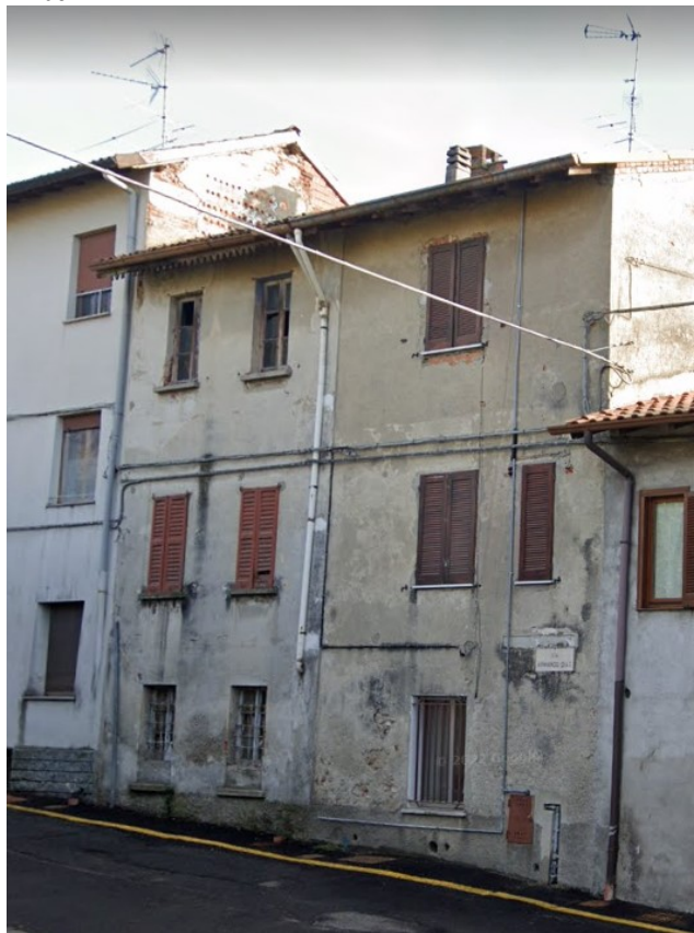
ID 06 – Porzione di edificio in via Diaz
