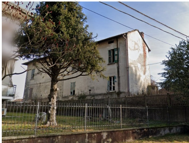
ID25 – Edificio sulla SP 31
